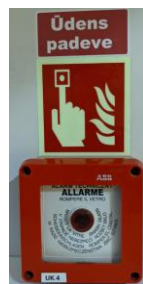
7.attēls. Elektroaizbīdņu distances vadības poga
